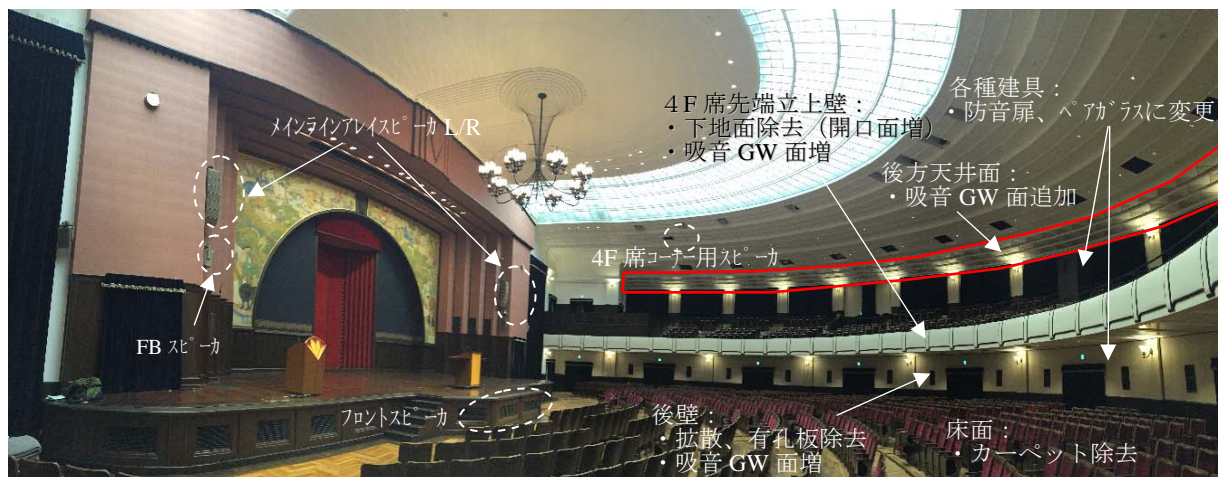
図2 改修後内観 音響改修内容概要
